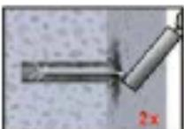
**Nota:** La limpieza inadecuada del orificio puede comprometer la capacidad de anclaje del producto.
